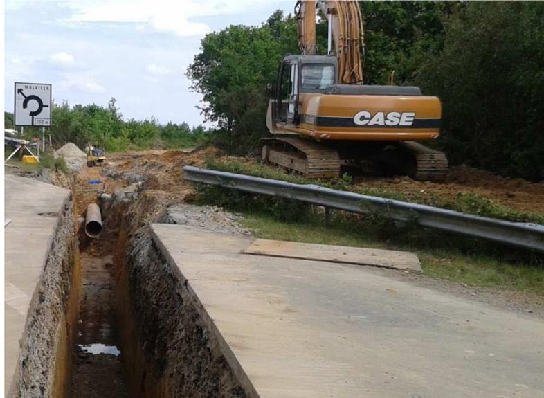
Figure 57 : Exemple de tranchée ouverte (source : SETEC hydratec)
