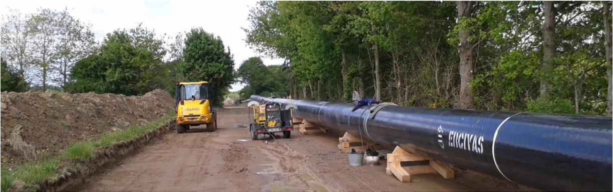
Figure 10 : Exemple de tubes assemblés (source : SETEC hydratec)
