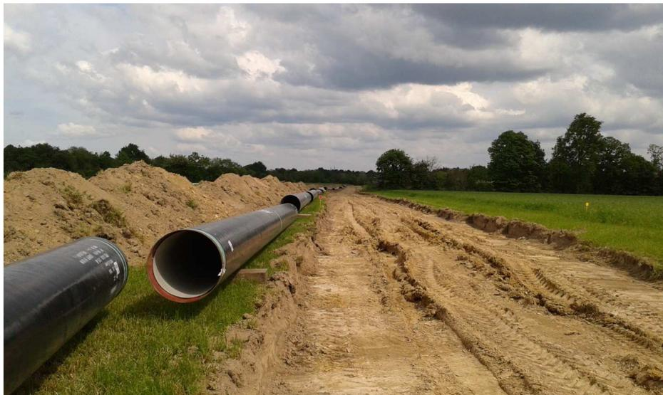
Figure 12 : Zone décapée et dépose des tubes (source : SETEC hydratec)
